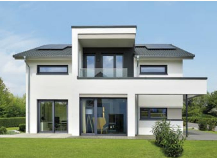
Bien-Zenker Musterhaus in Erfurt Flachdachanbauten erweitern den Wohnbereich und spendieren den Kinderzimmern im Dachgeschoss einen Balkon.
